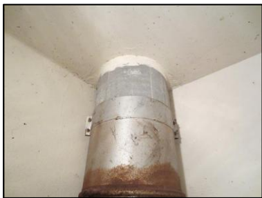
Photo N° 685 AMIANTE CIMENT 7 LORIENT--RDC--V.O Vide-ordures Gaine V.O.(Fibres-ciment)
